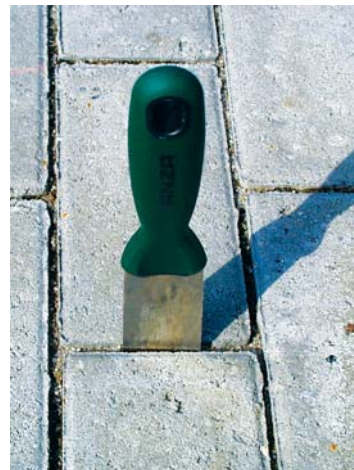
Fugebredden kan kontrolleres 10 mm under belægningsoverfladen ved nedstik med søgerblad o.l. Foto: Belægningsfraktionen, DBI.
