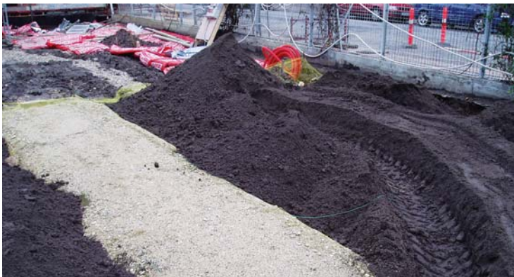
Eksisterende forurenset jord er gravet væk og i stedet er udlagt en deklareret muld. Der foreligger analyse for næringsværdier og tekstur. Mulden er nem at håndtere og har et godt luftskifte. Foto: Solum gruppen.
