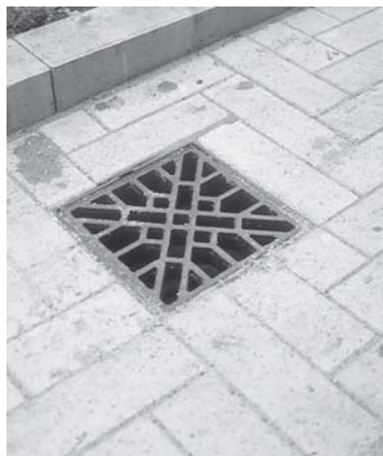
Dækslers og ristes mål bør passe med belægningens byggemål eller skifter. Foto: Torben Dam.
